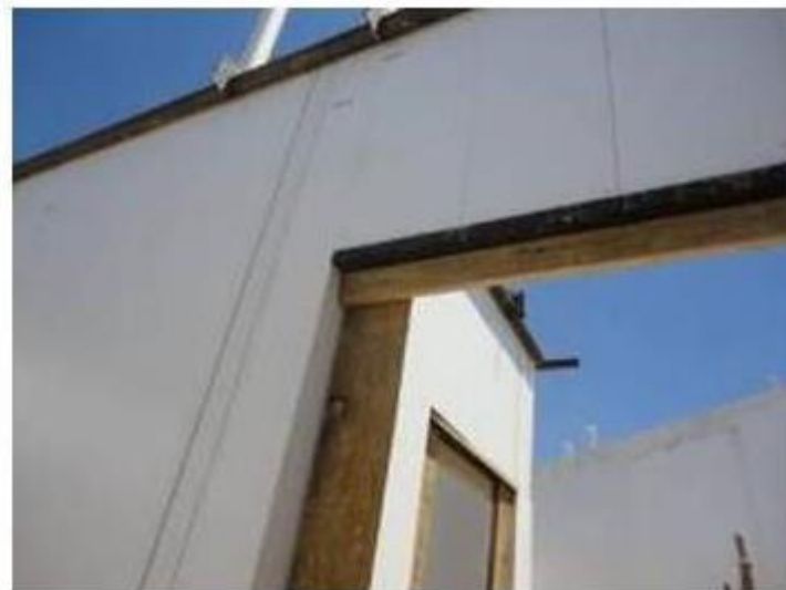
FIGURA 21 – Escoramento de aberturas de portas para concretagem
