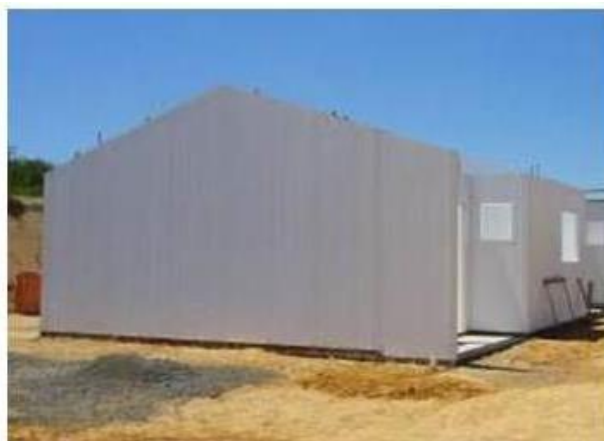
FIGURA 22 – Painéis de PVC concretados
