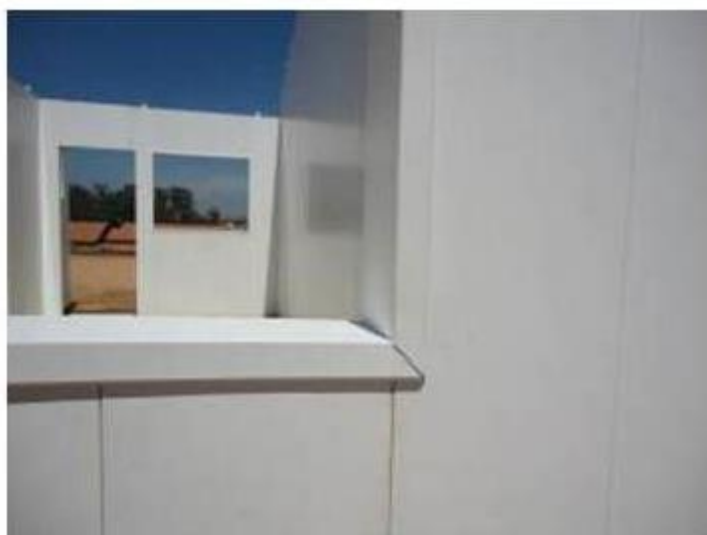
FIGURA 23 – Abertura das janelas com acabamentos em PVC
