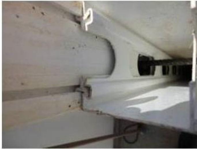
FIGURA 20 – Ferragem posicionada na região da contra-verga
