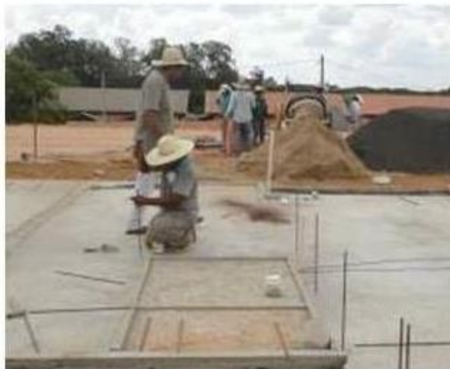
FIGURA 16 – Elemento de fundação com planicidade adequada
