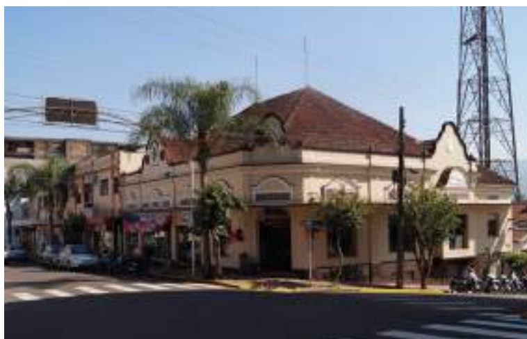
FIGURA 58: Rua Dr. João Carlos Machado em 2019, onde se observa a transformação do cenário urbano, no entanto a fachada da antiga Casa Moesch continua intacta.
