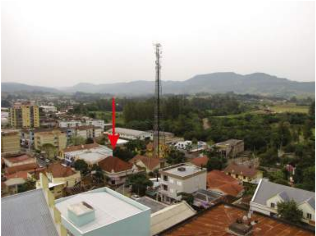
FIGURA 60: Vista do Centro de Arroio do Meio em 2010, destacando a Casa Moesch Fonte: Acervo fotográfico do CMDPU/MCN/Univates (2019).
