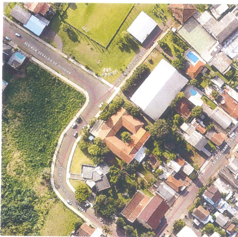
Imagem 1 – Localização da Escola Construindo o Saber
